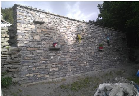
Parement en pierre du mur de soutènement du parking du Villard Réalisé par l'entreprise Construction des Cimes.
