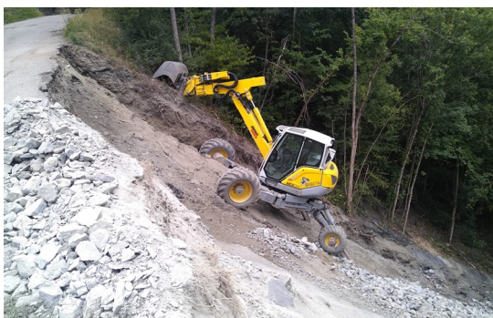
Travaux de reprise du soutènement de la route du Parchet et mise en place d'une canalisation et d'un regard pour l'écoulement des eaux pluviales.
