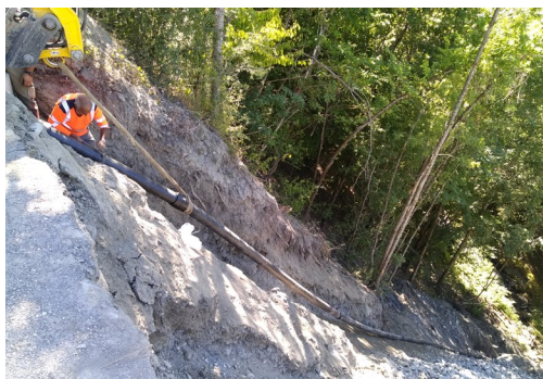
Travaux de reprise du soutènement de la route du Parchet et mise en place d'une canalisation et d'un regard pour l'écoulement des eaux pluviales.
